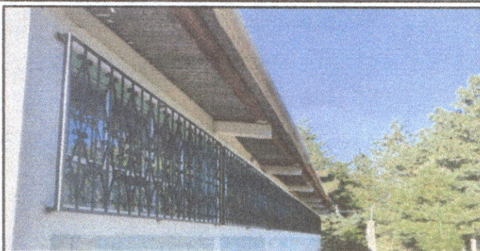
Foto 2: parte de atrás y fabricacion e instalacion de balcones en ventanas MODULO1
