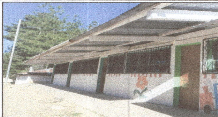
Foto 1: parte de enfrente fabricacion e instalacion de balcones de hierro en ventanas MODULO 1
