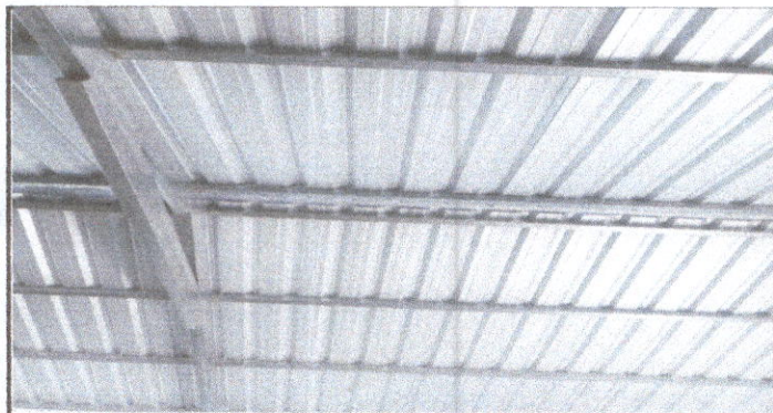
Foto 3: Sustitucion de estructura de soporte de madera por metal MODULO 2
