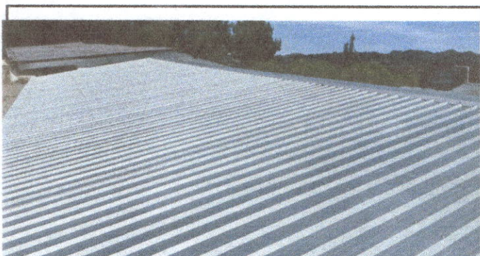
Foto 5: Sustitucion de lamina troquelada aluzinc calibre 26 MODULO 2
